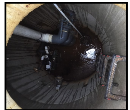
Espacio confinado en el sistema de almacenamiento de estiércol.
